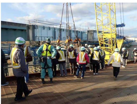
（阿武隈大橋工事現場見学）
