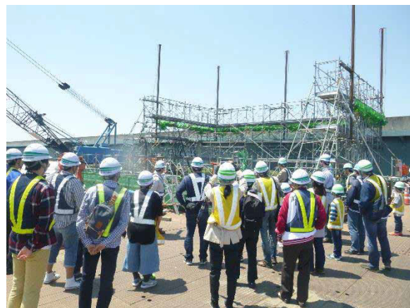
(阿武隈大橋工事現場見学)
